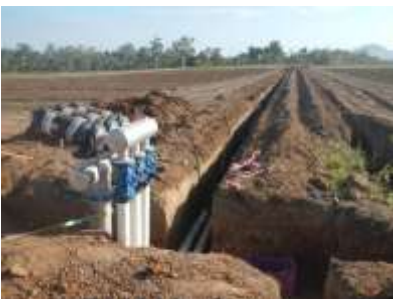
Installation des Bewässerungssystems
